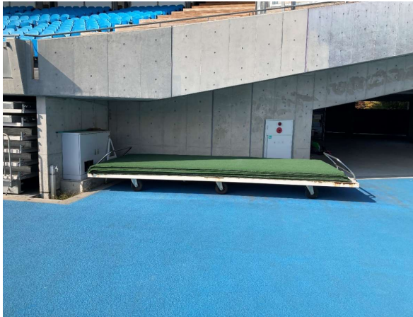
バックスタンド下の倉庫内
